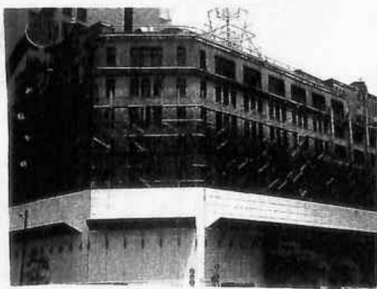
↑ かつて三信ビルの解体工事が行われていた
